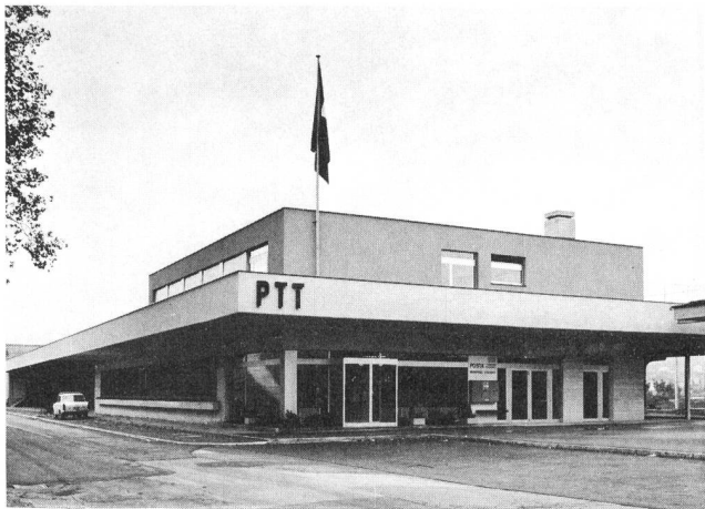
Fig. 1 Ausgedehnte Vordächer schützen die Betriebsräume einer Post vor übermässiger Sonneneinwirkung – Des avant-toits étendus protègent les locaux d'exploitation d'une poste contre les effets excessifs du rayonnement solaire
