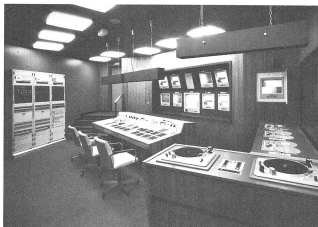
Fig. 15 Régie son d'un grand studio de production – Tonregie eines grossen Produktionsstudios
