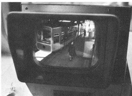
Fig. 2 Beispiel eines auf drahtlosem Wege übertragenen Fernsehbildes auf dem Monitor im Führerstand
