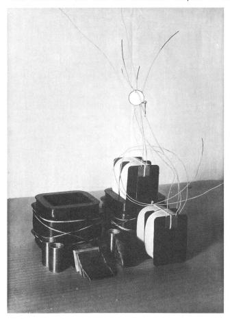
Fig. 1 Eléments d'une bobine à manteau (1930...1934)
