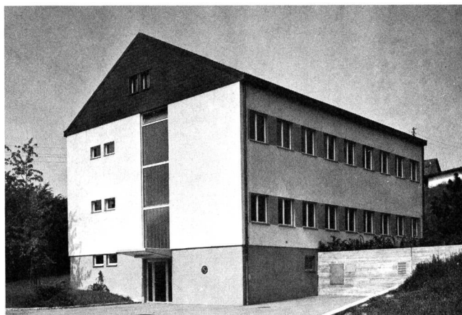
Fig. 8 Telefonzentrale Typ 4, mit Eingang im Untergeschoss – Central téléphonique type 4, avec entrée au sous-sol
