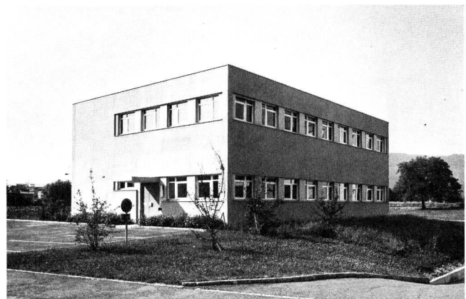
Fig. 7 Telefonzentrale Typ 4, mit Eingang im Erdgeschoss – Central téléphonique type 4, avec entrée au rez-de-chaussée
