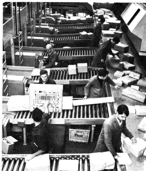
Fig. 4 Codierplätze einer modernen elektronisch gesteuerten Paket-Sortieranlage
