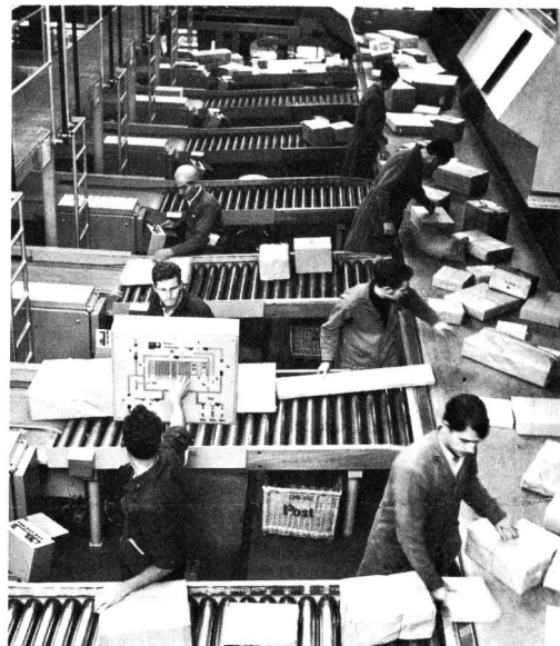
Fig. 4 Codierplätze einer modernen elektronisch gesteuerten Paket-Sortieranlage
