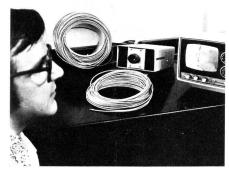
Misure di attenuazione su lunghi tratti di guide d'onda ottiche. La Corning è riuscita a produrre guide d'onda in vetro lunghe fino a tre chilometri con attenuazione media di 4 dB/km
