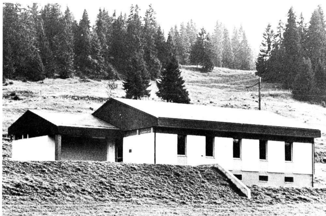
Fig. 1 Central téléphonique du modèle 2 (Les Charbonnières dans le Val de Joux) - Centrale telefonica tipo 2 (Les Charbonnières nella Valle di Joux)
