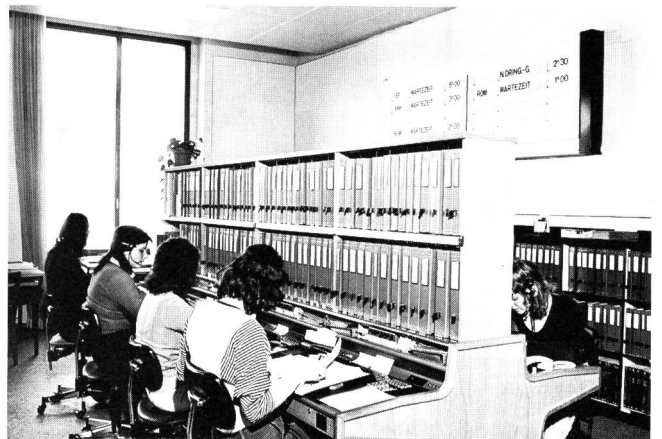
Fig. 5 Ticketergänzungsplätze im manuellen Fernamt Bern – Positions de contrôle des tickets au central manuel interurbain de Berne
