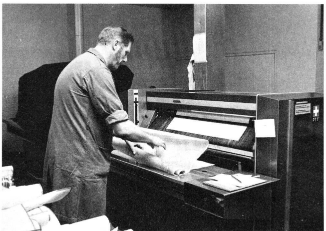
Fig. 6 Héliografieren von Plänen – Héliographie de plans
