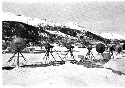
Fig. 4 Das Richtstrahlrelais in St. Moritz-Bad. Die Parabolantennen waren auf dem Dach eines Hochhauses platziert
