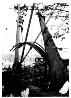
Fig. 4 Anlanden und Ausbau des Spülrohres am Zielufer
