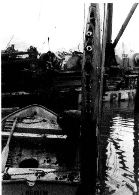
Fig. 3 Detail der an der Schneide sichtbaren neun Spülrösen
