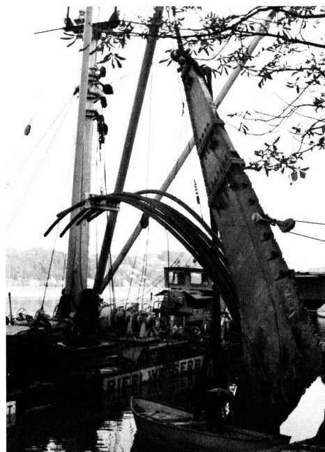
Fig. 4 Anlanden und Ausbau des Spülrohres am Zielufer
