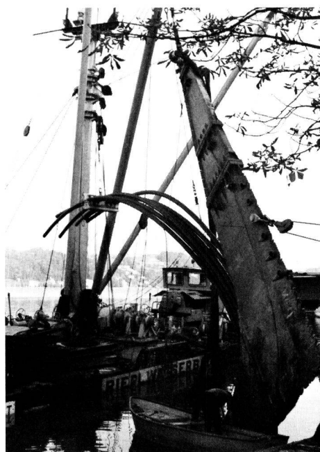
Fig. 4 Anlanden und Ausbau des Spülrohres am Zielufer
