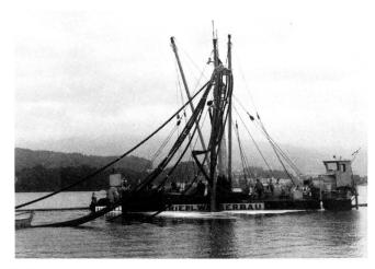
Fig. 2 Einsetzen des Spülrohres
