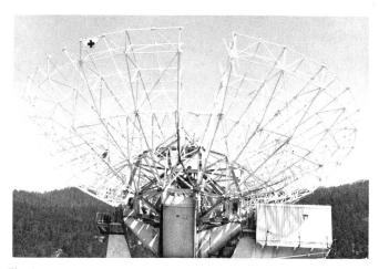
Fig. 8 Reflector backup structure — Configuration arrière du réflecteur
