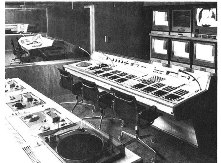
Fig. 3 Regieräume für Bild, Ton und Licht des Studios 1
