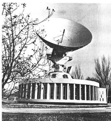
Fig. 3 Eine der russischen Satelliten-Bodenstationen mit der auf das Betriebsgebäude aufgesetzten (meist) 12 m grossen Parabolantenne
