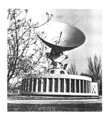
Fig. 3 Eine der russischen Satelliten-Bodenstationen mit der auf das Betriebsgebäude aufgesetzten (meist) 12 m grossen Parabolantenne
