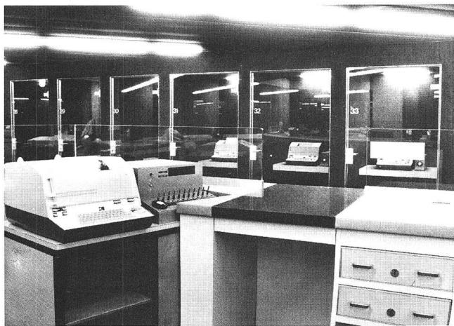
Fig. 3 Position de l'opératrice chargée de l'exploitation des cabines télex
