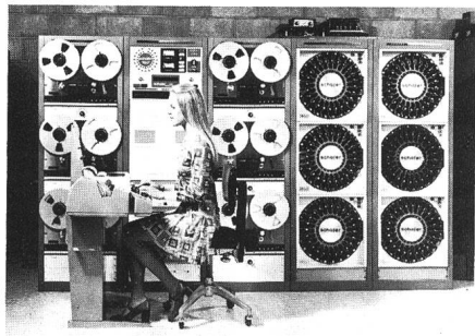
Fig. 5 Programmgesteuerte Bildmagnetband-Abspiel-einheit für Spulen und Kassetten (rechts) – Unité de reproduction de bandes magnétiques vidéo, commandée par programme, pour bobines et cassettes (à droite)
