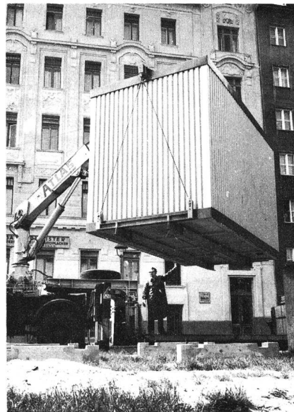
Fig. 3 ▷ In der Endphase der Vollautomatisierung waren rund 150 transportable Zentralen aufgestellt
