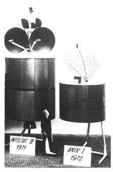
Fig. 2 Vergleich von Intelsat IV (links) und Anik, Kanadas nationalem Satelliten für die Vermittlung von Telephongesprächen, Telex, Radio- und Fernsehprogrammen
