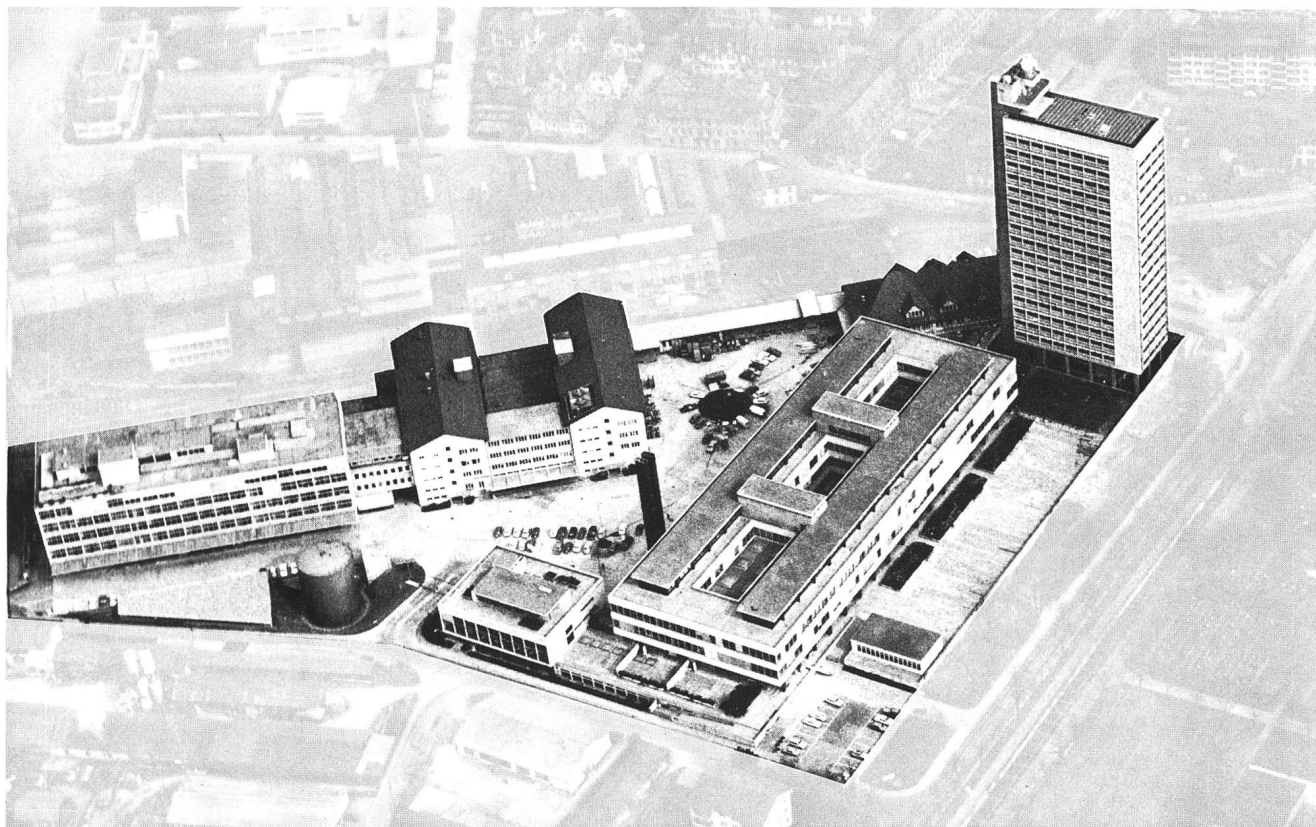
Fig. 1 Gesamtansicht des Technischen Zentrums PTT Bern-Ostermündigen Vue générale du centre technique PTT de Berne-Ostermündigen
