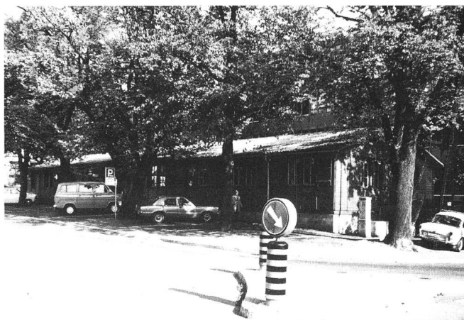
Fig. 1 Provisorisches Annahmeamt Solothurn 1 als PTT-Holzbau Office de dépôt provisoire de Soleure 1 logé dans une construction en bois des PTT
