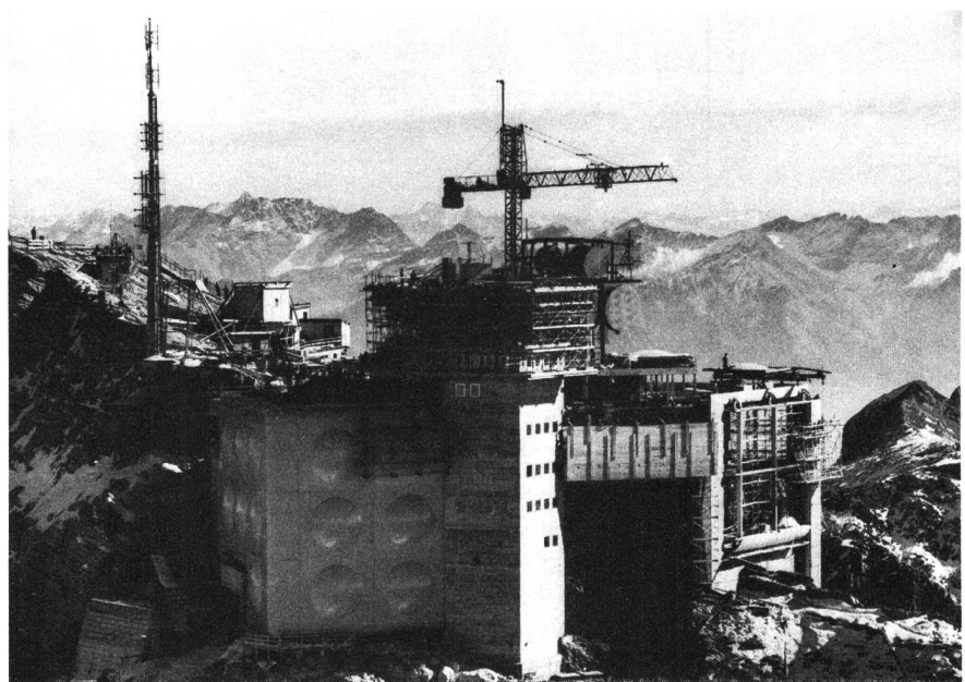
Fig. 1. Baustelle Säntis kurz vor der Aufrichte. Rechts der Bahneinfahrt ist die noch unverschaltete, links die bereits verkleidete Antennenkaverne zu erkennen
