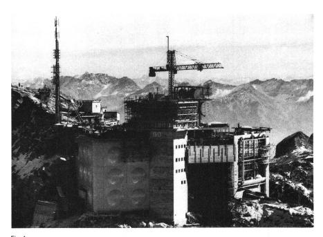
Fig. 1° Baustelle Säntis kurz vor der Aufrichte. Rechts der Bahneinfahrt ist die noch unverschalte, links die bereits verkleidete Antennenkaverne zu erkennen
