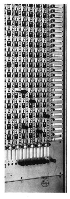
Die Kreuzschienenbucht von Philips bietet – von einem Standort aus zu überblicken und zu bedienen – 60 mal 80 Durchschaltungen. Weil sie von vorne zugänglich ist, kann sie an einer Wand aufgestellt werden, was nochmals Platz erspart.
