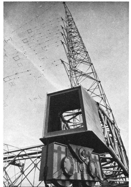
Fig. 3 Detailaufnahme des Rollschemels – Vue de détail d'un bogie
