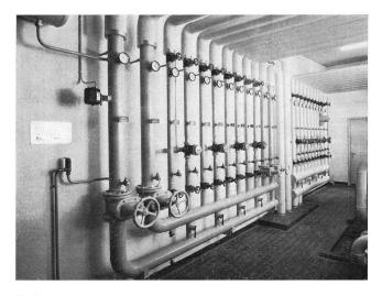
Fig. 7 Heiz- und Kühlverteiler für die Klimaanlagen «Erdgeschoss bis Dachgeschoss»
