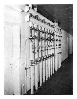
Fig. 5 Heiz- und Kühlverteiler für die Klimaanlagen im Untergeschoss
