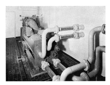
Fig. 10 Turbokältemaschine
