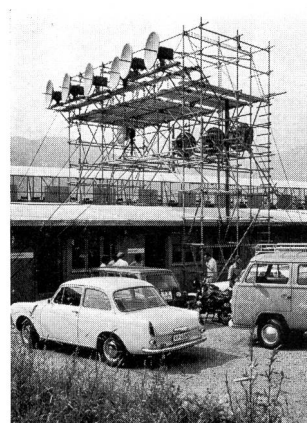
Fig. 6 Supporto d'antenna al centro di Vignalonga
