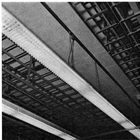
Fig. 32 zweiflämmige Fluoreszenzleuchten mit Lytespanschiene und Ketten an der Decke des Verstärkeramtes befestigt
