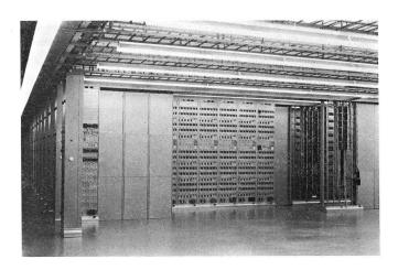
Fig. 19 Im Vordergrund die angefangene Reihe 29, dahinter der fertige Block der Reihen 27 und 28. Links die Flucht der Reihenspeiseverteilgestelle
