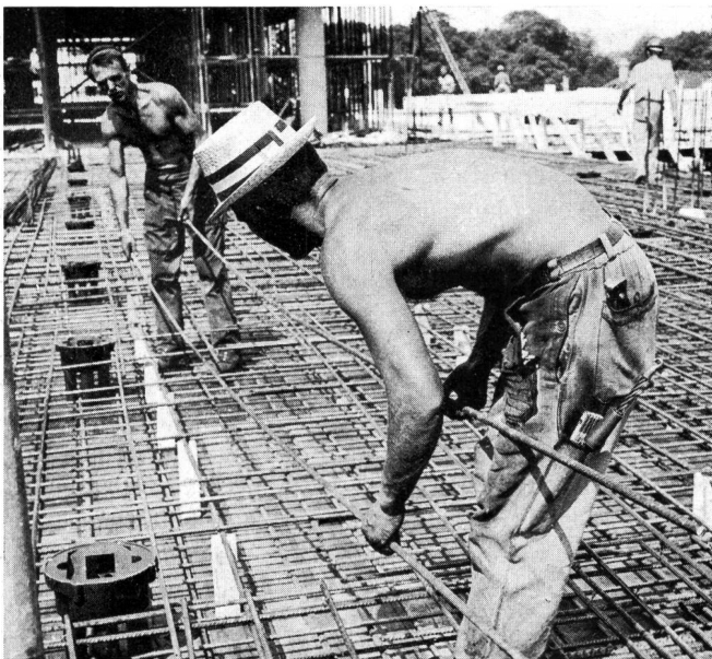
Fig. 19 Einbau der Bodendosen in Betonschalung Montage des boîtes de sol dans le coffrage
