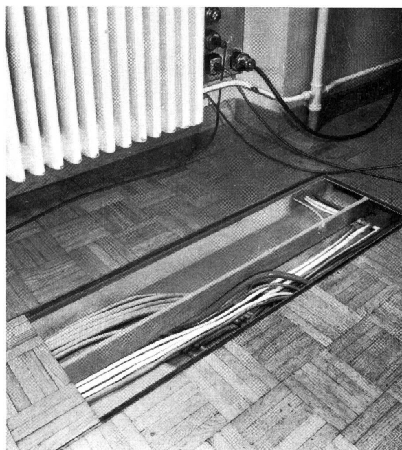
Fig. 15 Nachträglich eingebautetes Bodenkanalsystem Système de canaux de sol montés après coup
