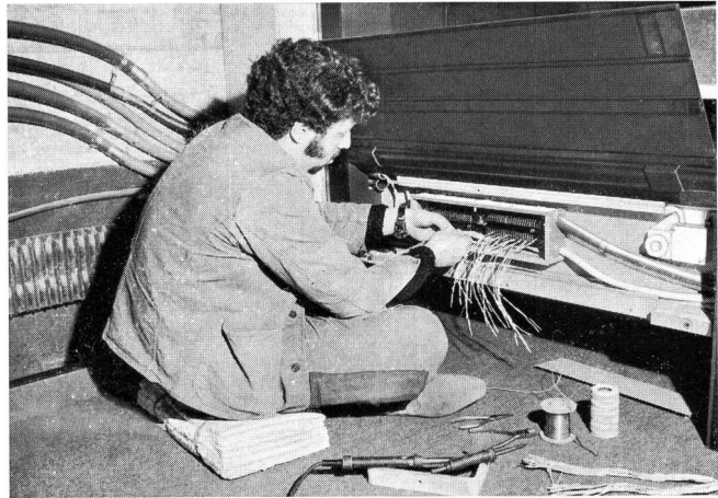
Fig. 7 Telephonspezialist beim Anschliessen eines Zwischenverteilers zum Einbau in Brüstungskanäle Spécialiste du téléphone raccordant un répartiteur intermédiaire pour montage dans canaux d'allège
