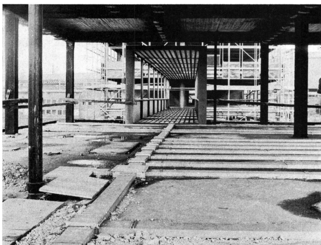
Fig. 13 Montageansicht von Bodenkanälen, Unterflursystem Vue du montage d'un système de canaux de sol noyés dans la chape
