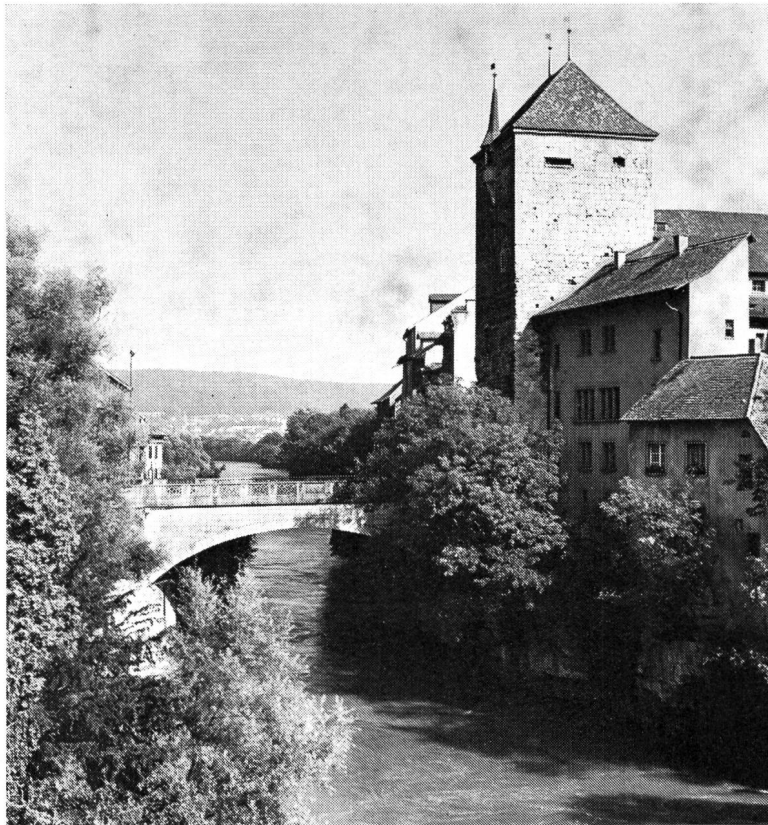
Das ist die Aarebrücke in Brugg. Sie verbindet Auseinanderliegendes, sie verkürzt Entfernungen. Wie die Kabel aus Brugg. Und weil man die Brücke tagein, tagaus benützen will, wurde sie so solide gebaut. Genau wie die Kabel aus Brugg.
