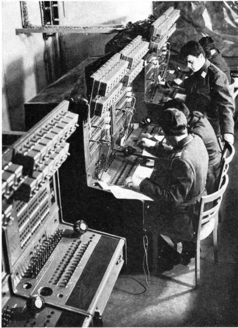
Fig. 10 Militärzentrale im Einsatz in Zürich-Hottingen. Später wurde sie von Telephonistinnen bedient Central militaire mis en service à Zurich-Hottingen. Il fut par la suite desservi par des opératrices
