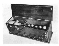
Fig. 3 Mehrkreis-Röhrenempfänger aus der Mitte der zwanziger Jahre
