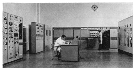
Salle d'émission des ondes moyennes à l'émetteur national de Sottens. De gauche à droite, bâti de contrôle et de mesure, tableau de courant fort et redresseur à haute tension, face du nouvel émetteur à ondes moyennes de 500 kW (à l'arrière-plan), partie de l'émetteur de réserve de 2 × 100 kW. Au milieu, pupitre de commande de l'émetteur de réserve
