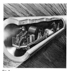
rig. 2 Verlegung des Fernmeldekabels mit Spezialfahrzeug im 24,1km langen Frischwasserstollen durch die Schwäbische Alb (Photos SEL)
