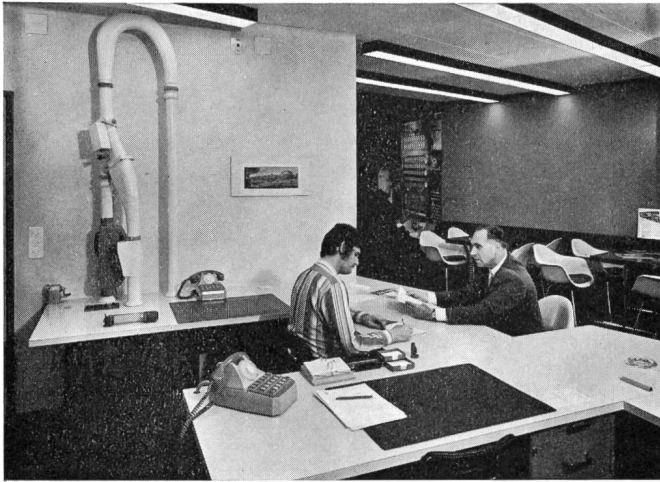
Fig. 8 Rohrpoststation mit Überfahrbogen in der Schalterhalle
