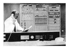
Blick in den Kontrollraum des Zentralgebäudes der Satelliten-Bodenstation Raisting. Von hier aus können sämtliche Einrichtungen, die der Nachrichtenübertragung und Antennensteuerung dienen, zentral überwacht und kontrolliert werden. Siemens-Pressebilder)
