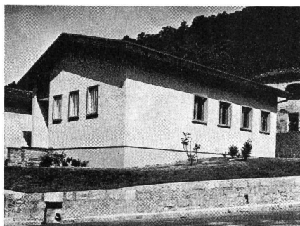
Fig. 2 La nuova centrale telefonica alla Malpensata
