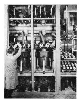
Fig. 2 Teilansicht der HF-Endstufe
