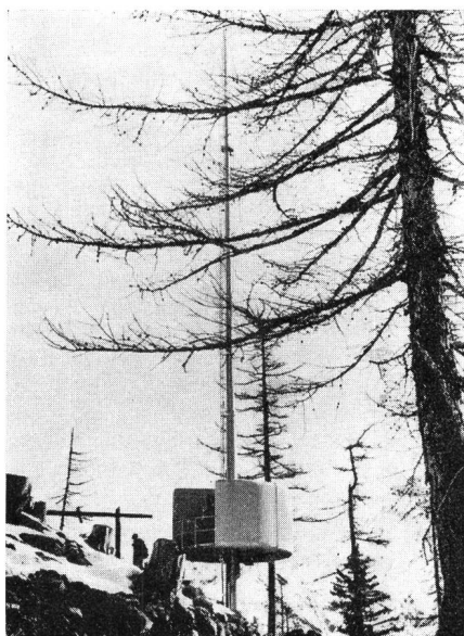
Fig. 1 Einer der Umsetzer der Simplonkette mit Sendermastkabine
