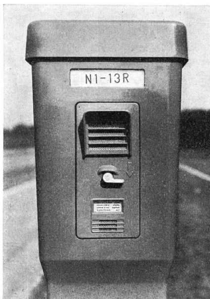
Fig. 3 Ruf- und Sprechsitz einer Notrufsäule
