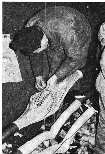
Fig. 4 Spleisser beim Isolieren der blanken Adern des Kabels 1200 \times 2
