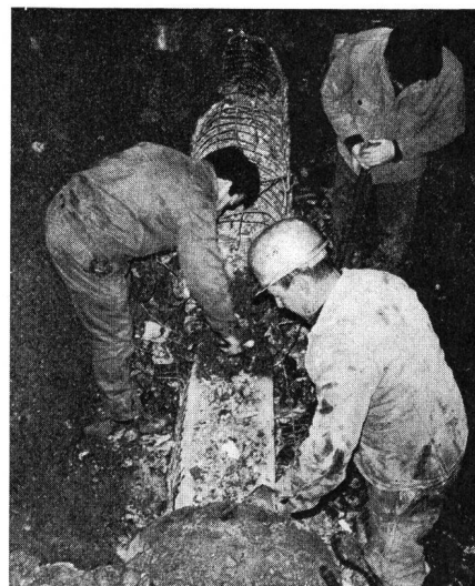
Fig. 2 Vom Erdreich freigelegte Betonrohrleitung
