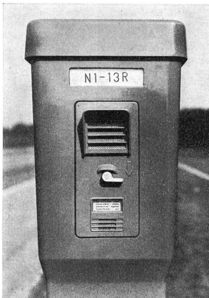
Fig. 3 Ruf- und Sprechsinsatz einer Notrufsäule
