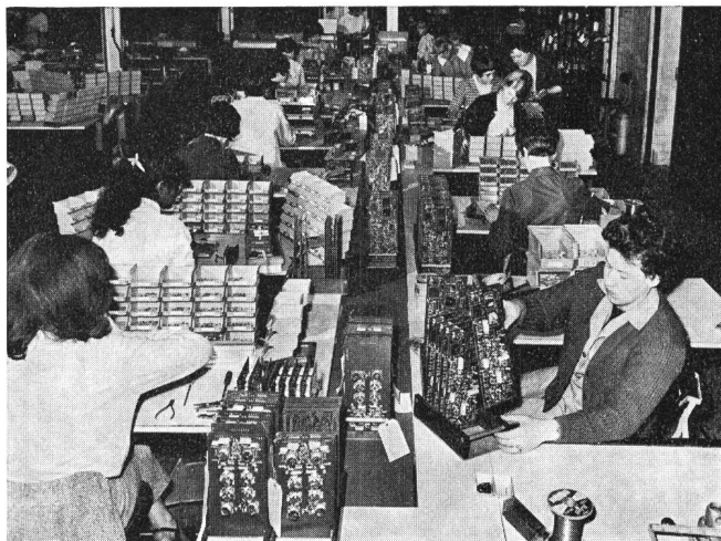
Fig. 1 Serienfertigung von PCM-Geräten in einem Werk in Coventry
