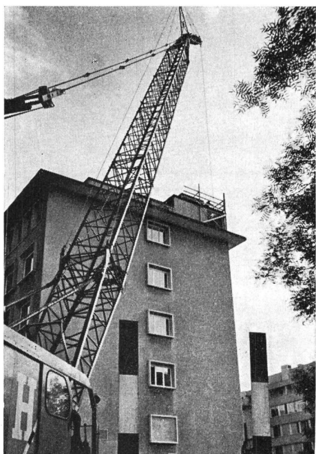
Fig. 12 Eine Kältemaschine wird in den Dachstock gehoben
