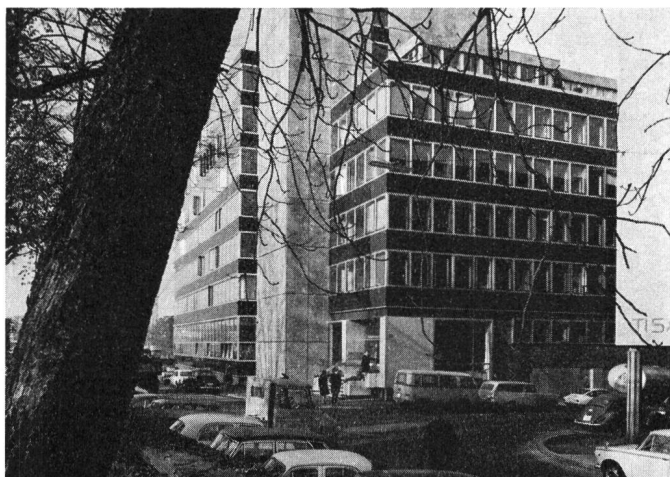
Fig. 1 Das neue Betriebs- und Verwaltungsgebäude der KTD Basel an der Wallstrasse von Südosten her gesehen
