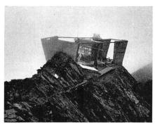
Fig. 6 Umlenkantennenanlage (Passivrelais) Gesero während des Baues
