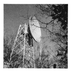
Fig. 5 Parabolspiegelträger Mte Ceneri
