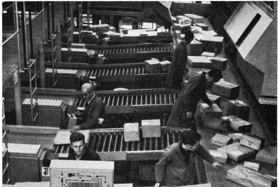
Fig. 3 Rechts das Zufuhrband für Pakete, an das sich rechtwinklig Rollenförderer anschliessen, die auf das Verteilband münden. Der Taster tippt auf ein Eingabegerät die beiden ersten Stellen der Postleitzahl ein. An der entsprechenden Stelle wird dann das Paket durch einen elektromechanischen Abweiser über eine Rutsche und allenfalls ein Querband zu einer bestimmten Umladestelle geleitet
