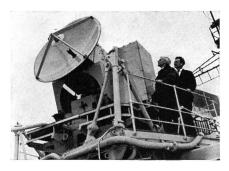
Fig. 2 Empfangsantenne von 1,8 m Durchmesser für den Einsatz auf Schiffen im Rahmen des Skynet-Fernmeldesatellitensystems
