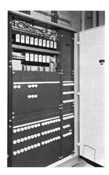
Fig. 61 Stockwerk-Verteilschrank
