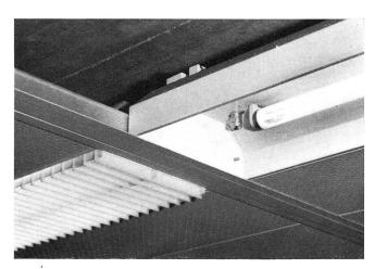
Fig. 62 Einbaudetail einer  $3 \times 40$ -W-Fluoreszenzarmatur (Raster zum Teil entfernt)
