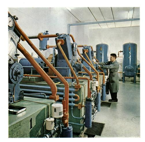
Fig. 52 Kompressorenanlage zur Druckluftversorgung der automatischen Türen und Tore, von Weichensteuerungen, Werkstätten usw.
