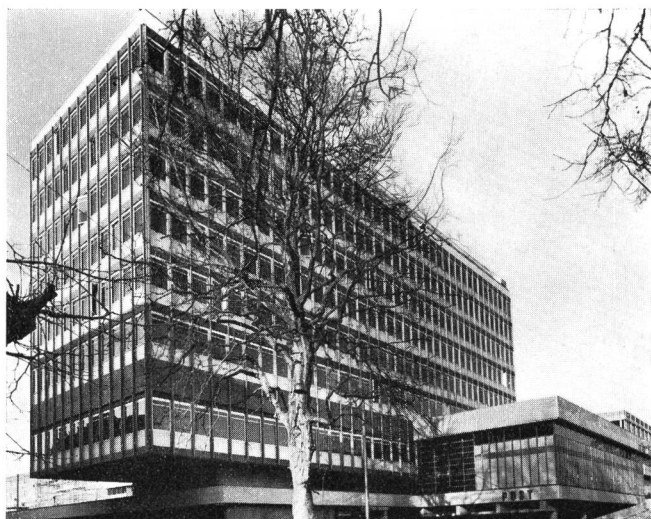
Fig. 10 Bürogebäude vom Burgerspital aus gesehen Bâtiment administratif vu de l'hôpital des Bourgeois
