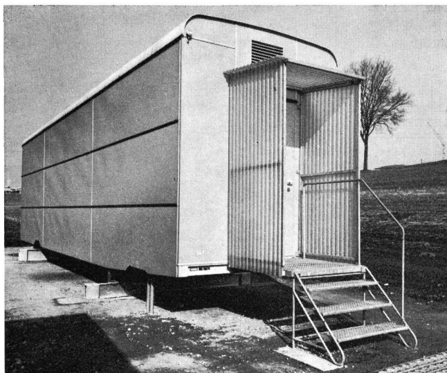
Fig. 5 Eingang zur Zentrale Entrée du central
