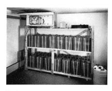
Fig. 2 Sender (oben) mit Primärbatterie 36 V/ 10 000 Ah
